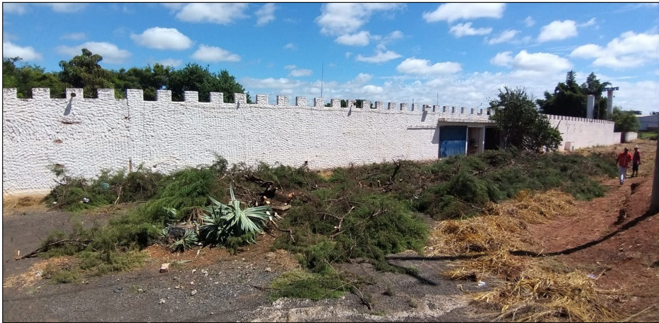
Futuras instalações da nova filial da Comunidade Terapêutica
